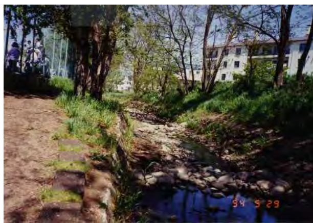
写真2 改修後（1994年5月29日）
