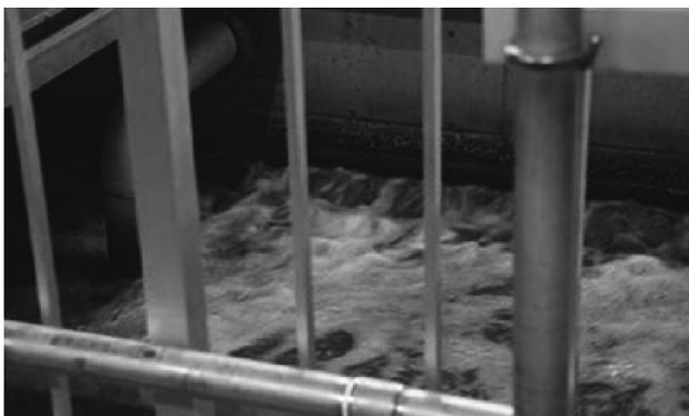
写真1 反応槽でのばっ気処理
