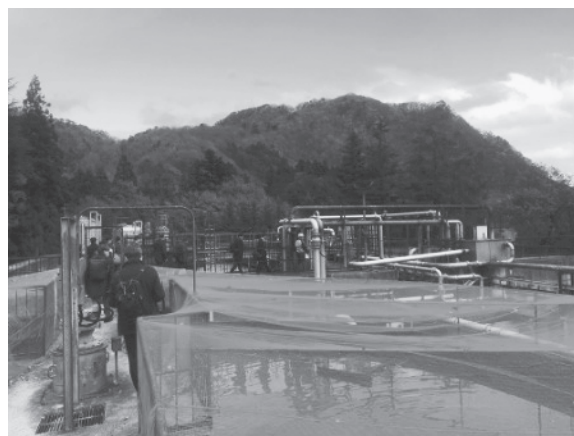
写真5 排水処理設備の見学の様子
