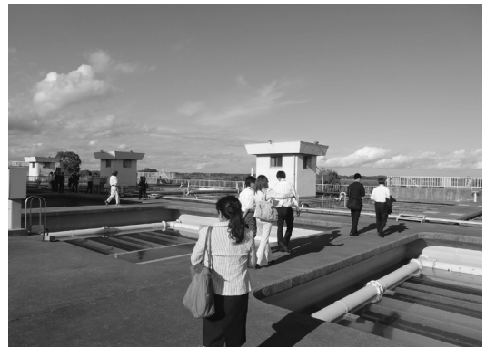
写真7 高速凝集沈殿池の見学
