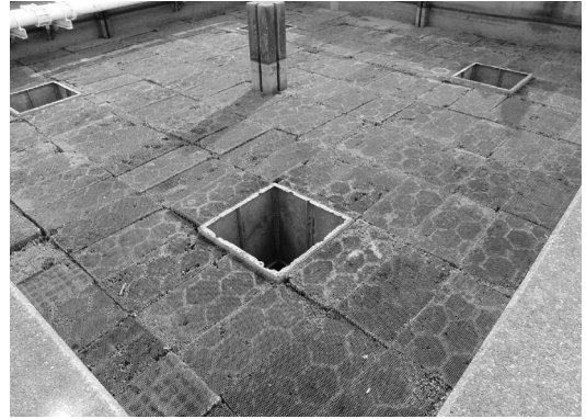
写真6 曝気槽内のハニカムチューブ
