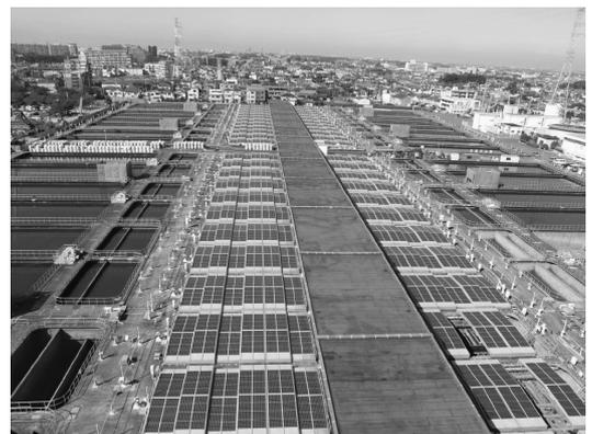
写真2 急速ろ過池に設置された太陽光発電設備
