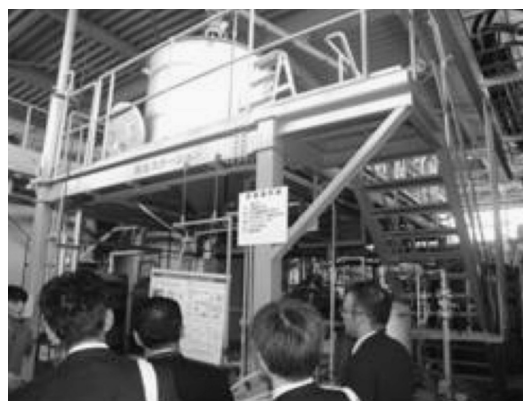
写真4 リン回収再生ステーション
