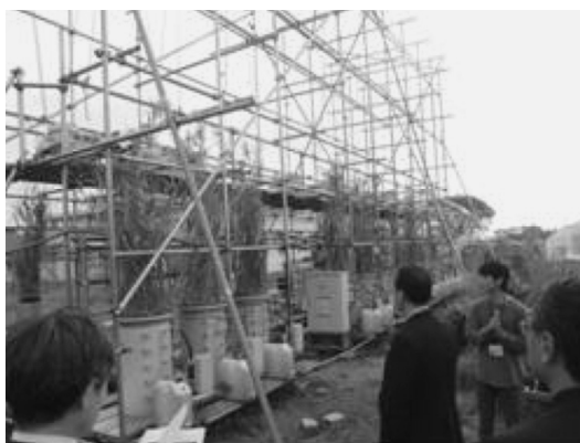
写真2 屋外植栽・土壌浄化実験フィールド①
