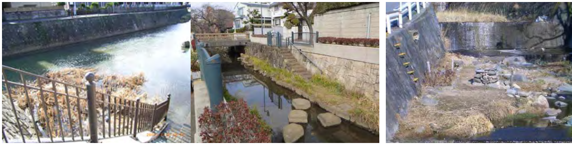
河川敷が狭いが，親水性に配慮し，階段を設置（横須賀市 田越川） 河川敷が狭いが，親水性に配慮し，階段を設置（東京都大田区 丸子川） 河川敷が狭く護岸垂直だが，親水性にやや配慮（山梨県 相川）
