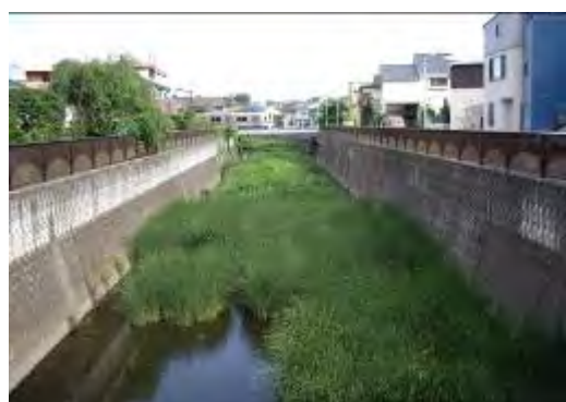
掘込河道の河川
