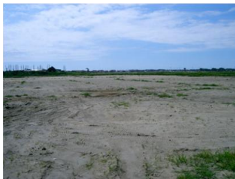
写真 6 キャタピラを付けた工事車両が駆け巡った跡:堆積ヘドロは風化が進む
